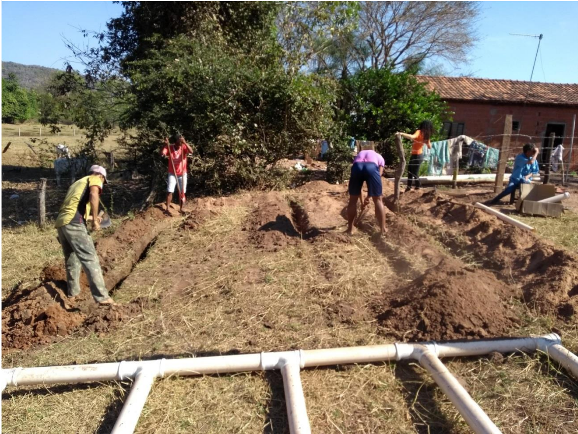
Figura 16 – Instalação das valas de infiltração.
