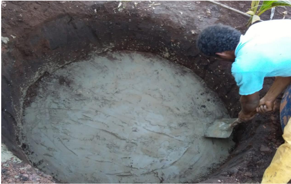
Figura 22 – Concretagem do piso da estrutura.
