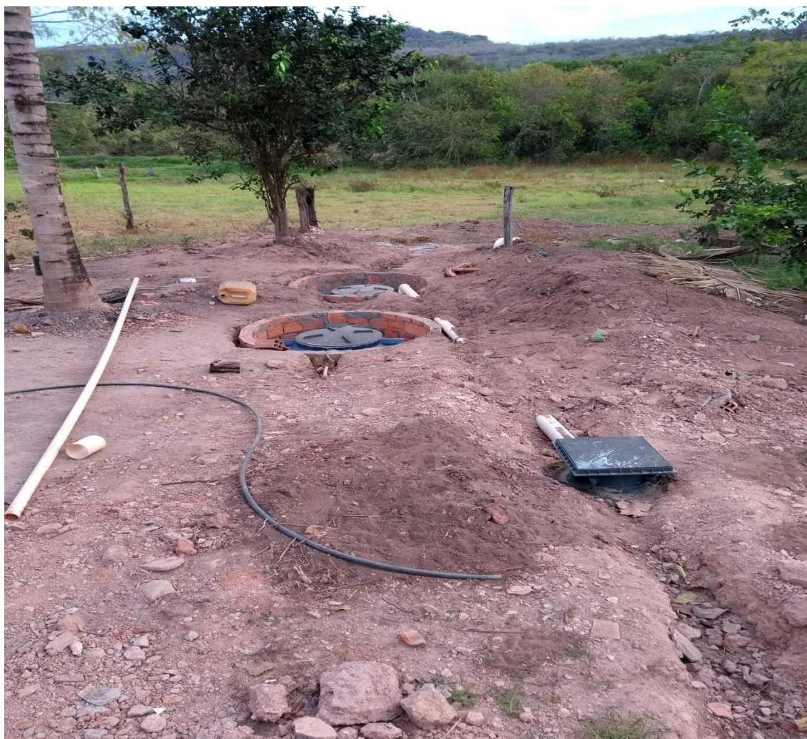
Figura 12 – Sistema pronto com a caixa de gordura devidamente instalada.
