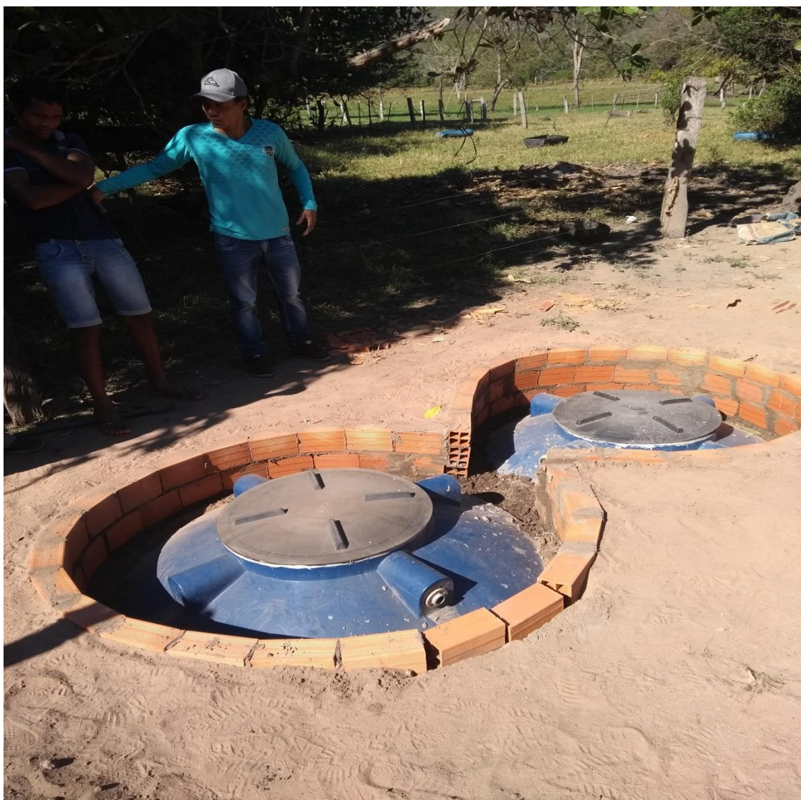
Figura 3 - Estrutura parcialmente pronta.
