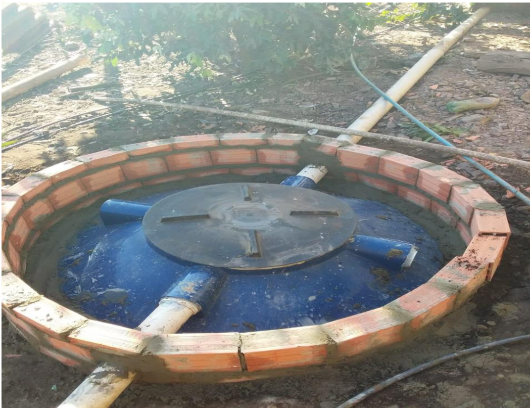
Figura 25 – Estrutura pronta e sistema operando.
