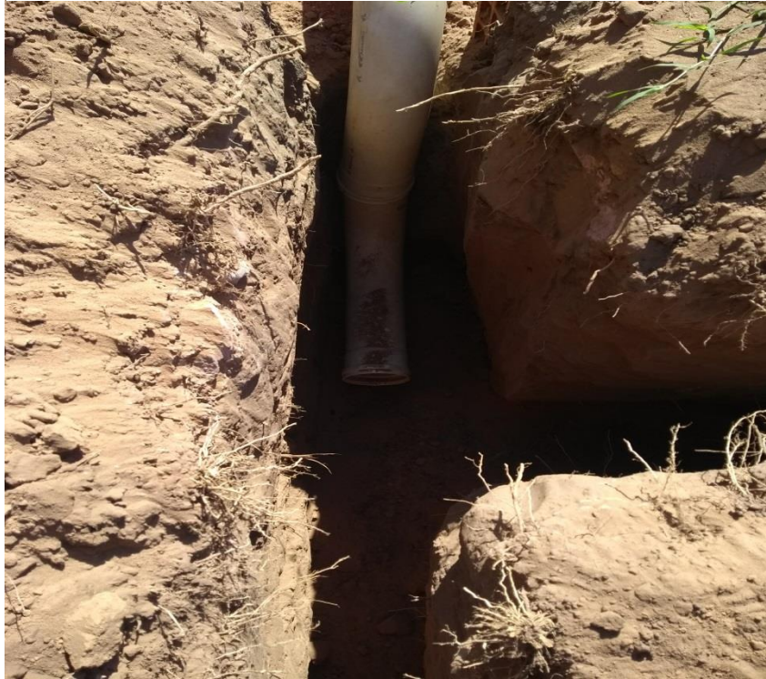
Figura 20 – Saída da segunda caixa e início do sistema da vala de infiltração.
