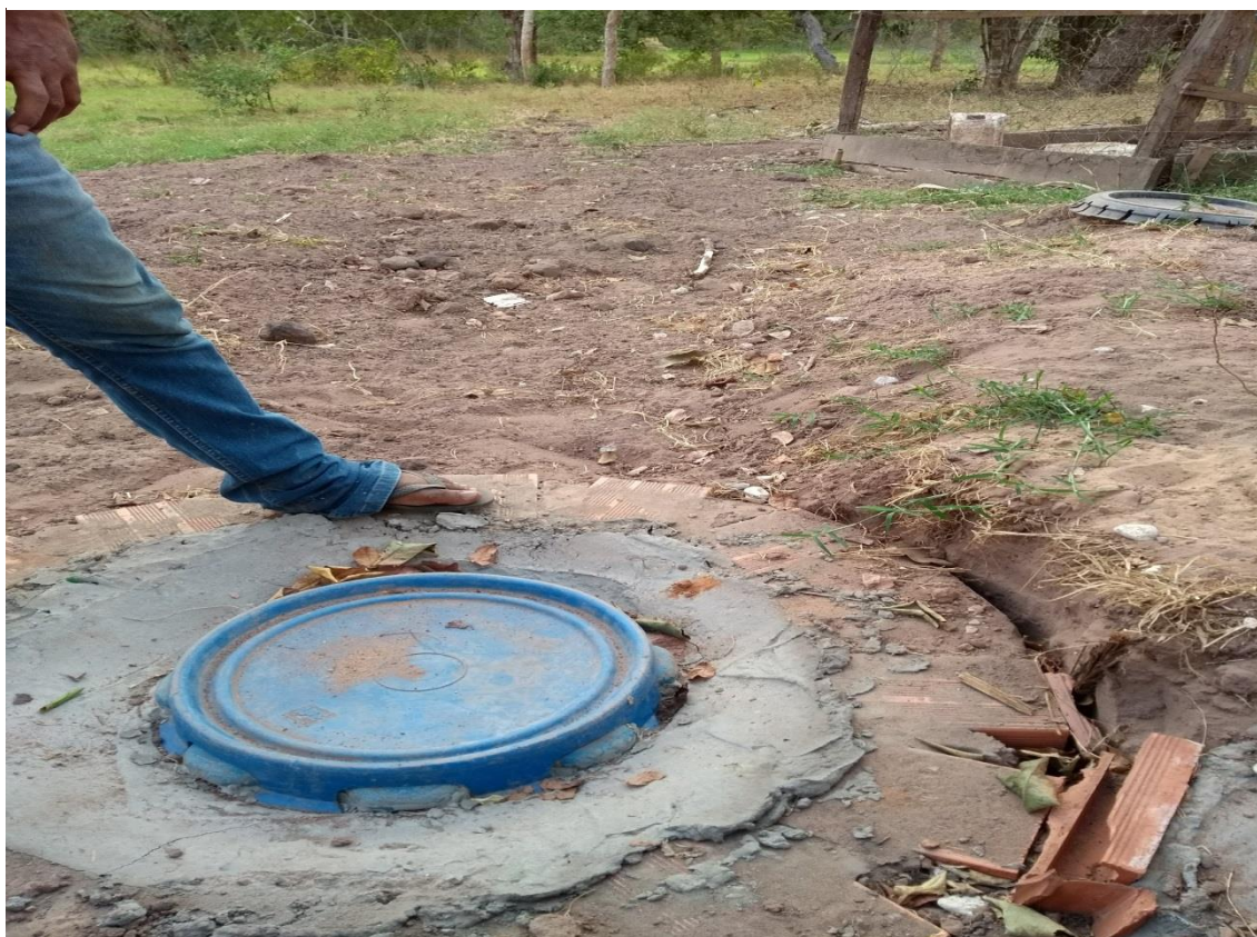
Figura 11 – Sistema caixa vala pronto.
