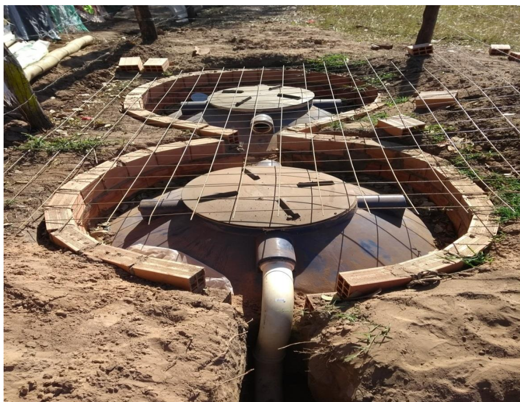
Figura 19 – Estrutura das caixas pronta.
