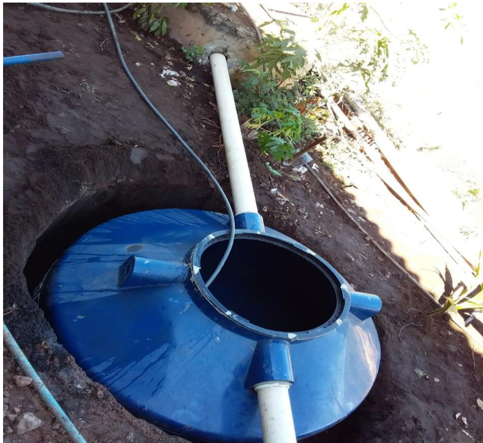
Figura 23 – Verificação do nivelamento do sistema.
