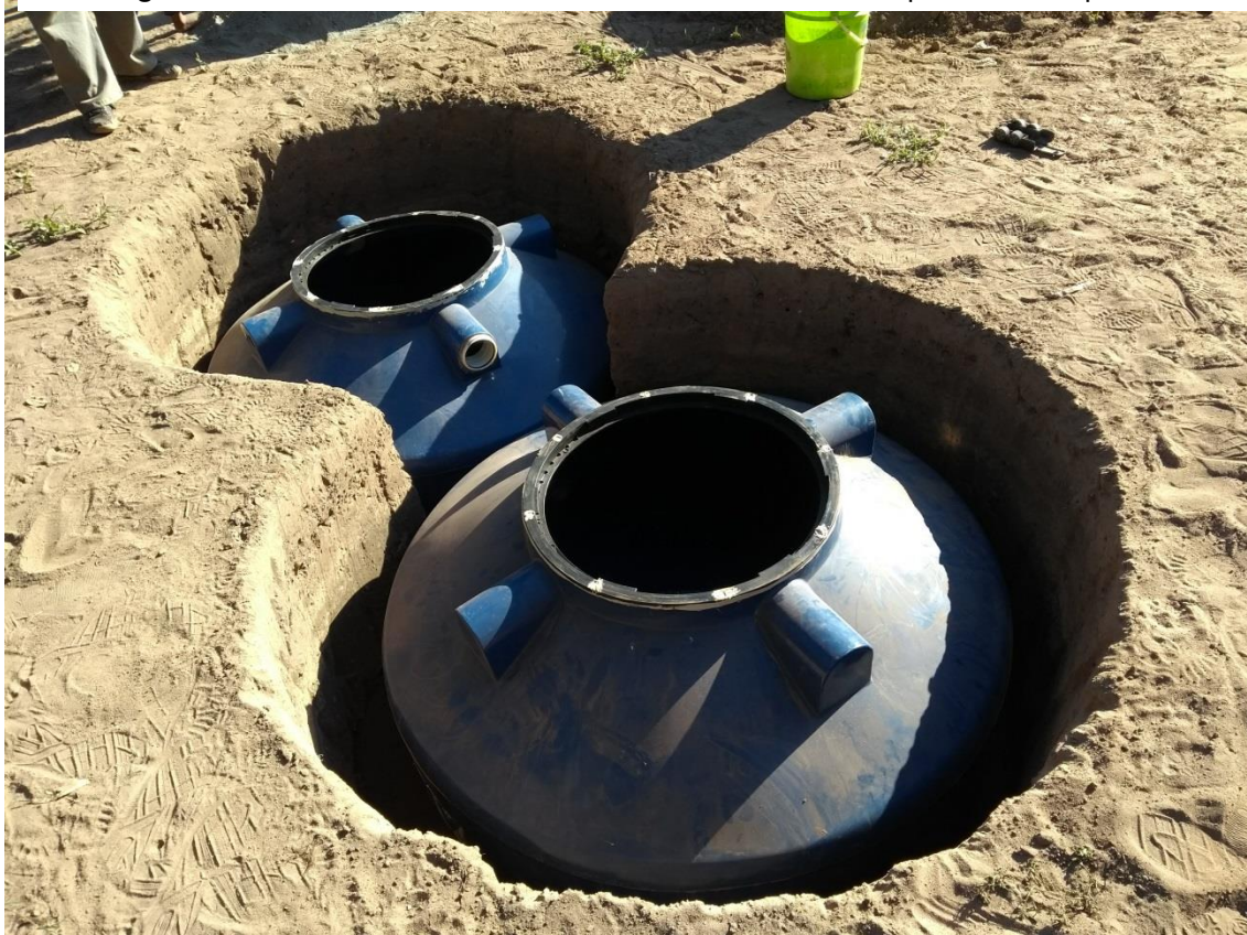
Figura 7 – Corte no solo feito de maneira correta e estrutura parcialmente pronta.
