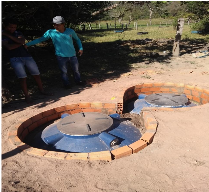
Figura 8 – Estrutura pronta, faltando apenas à tampa de concreto.
