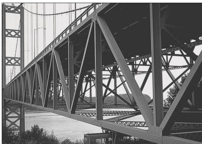
Figura 3: A ponte Tacoma-Narrows reconstruída, mostrando as treliças usadas para enrijecer o sistema de piso da pista de rolamento (Leet, Uang, Gilbert, Fundamentos da Análise Estrutural,2010).
