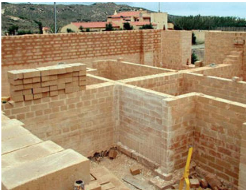
Figura 12 - Construção de alvenarias com a utilização de BTC.
