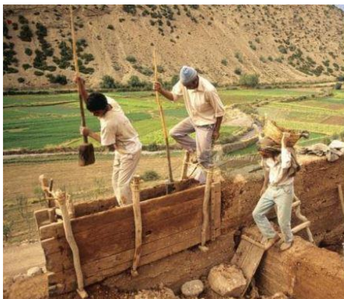
Figura 10 - Compactação do solo.
