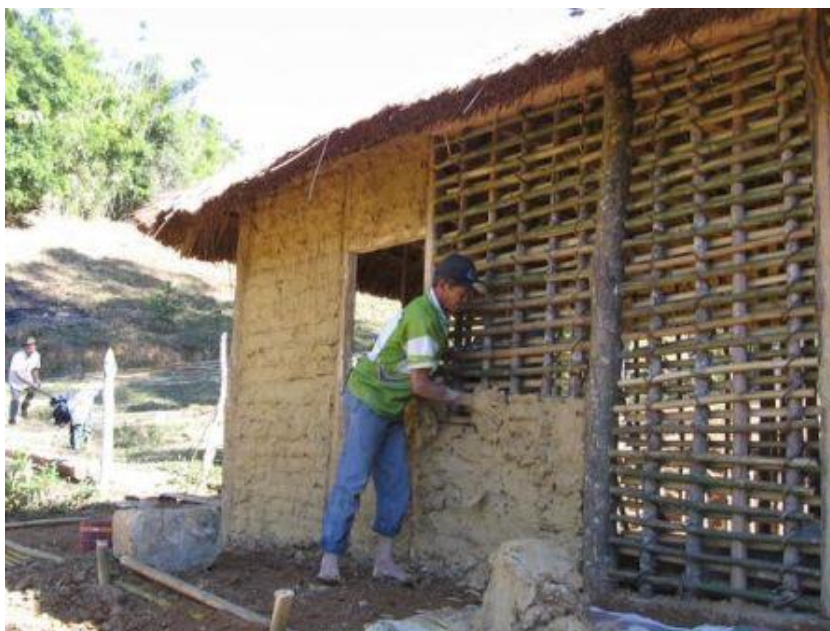
Figura 11 - Aplicação do barro na estrutura vegetal.
