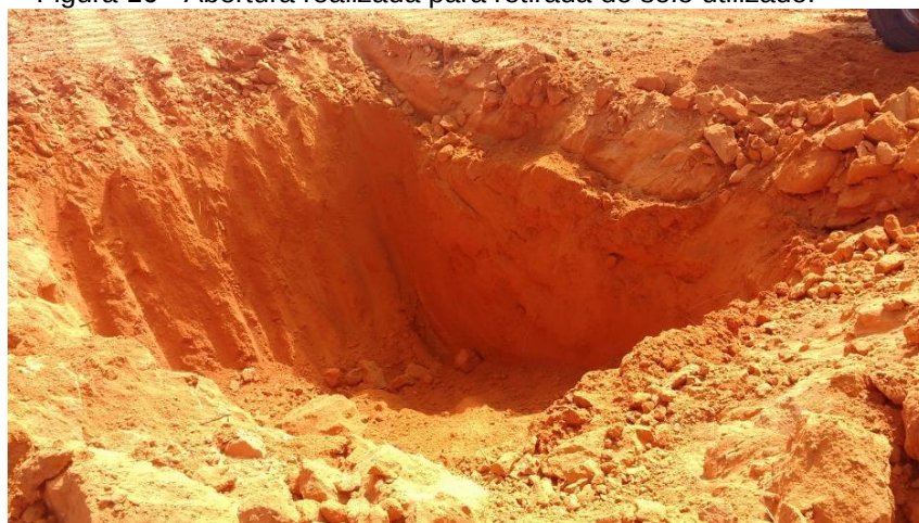
Figura 16 - Abertura realizada para retirada do solo utilizado.
