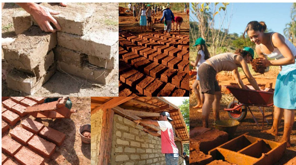
Figura 11 - Construção e produção de adobe.
