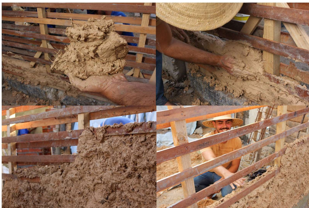
Figura 8 - Construção em taipa de mão.
