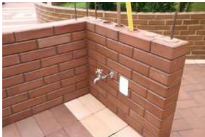
Figura 13 - Passagem de tubulações.
