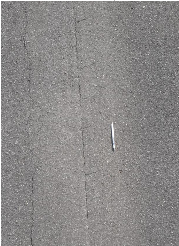
Fotografia 10 – Trinca couro de jacaré (Cabeceira 25 – Amostra 2)
