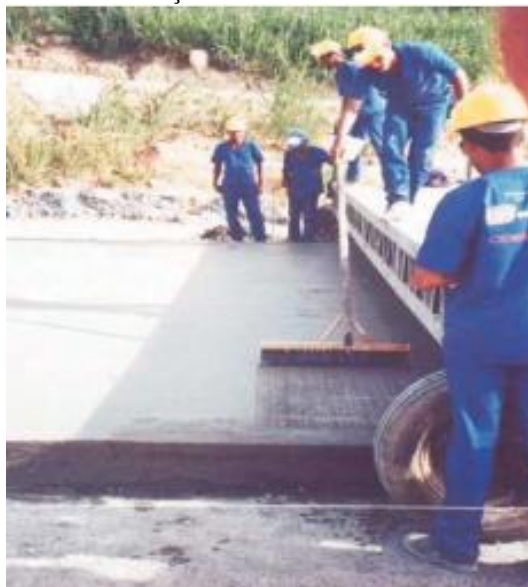
Figura 7 – Texturização manual com vassoura de fios duros
