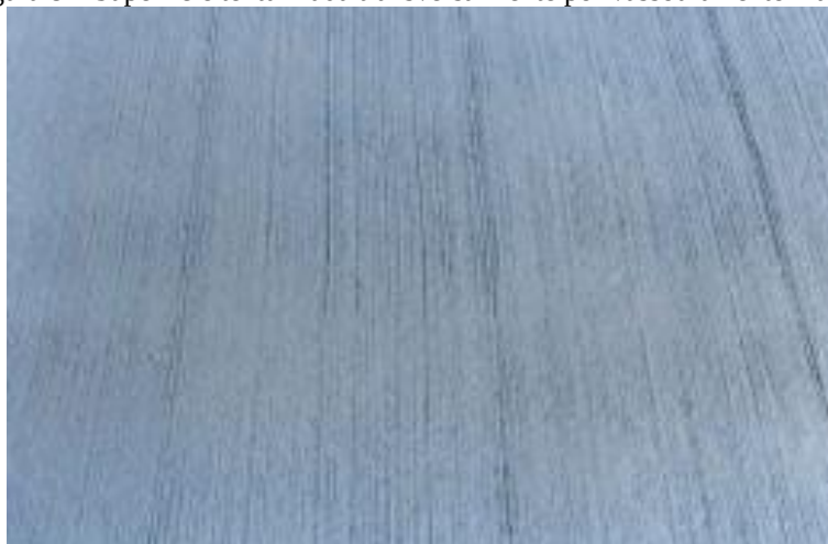
Figura 8 – Superfície texturizada transversalmente por vassouramento manual
