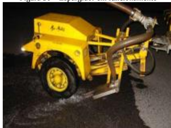
Figura 30 – Espargidor em funcionamento
