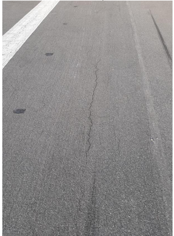
Fotografia 12 – Trinca longitudinal (Cabeceira 25 – Amostra 3)
