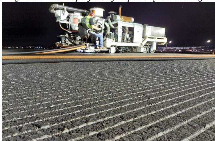
Figura 10 – Texturização grooving em pista de pouso e decolagem
