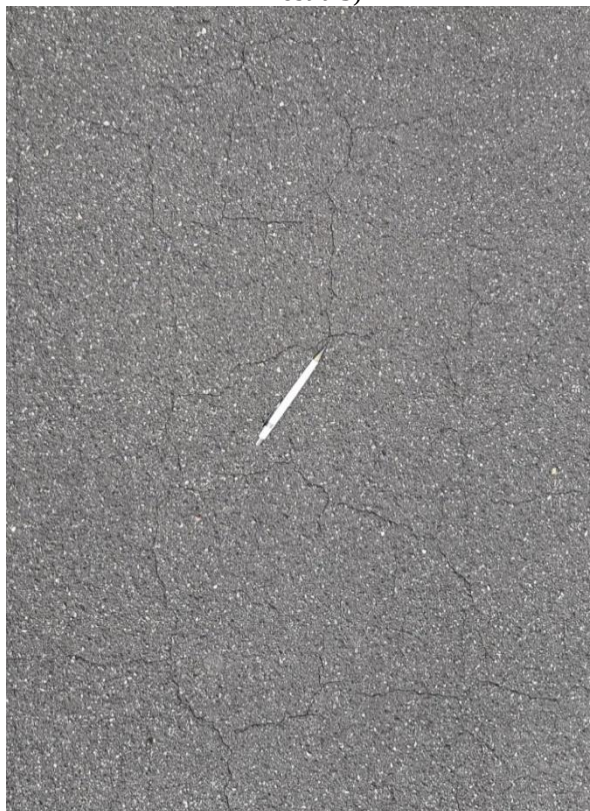
Fotografia 8 – Trinca couro de jacaré (Cabeceira 25 – Amostra 1)
