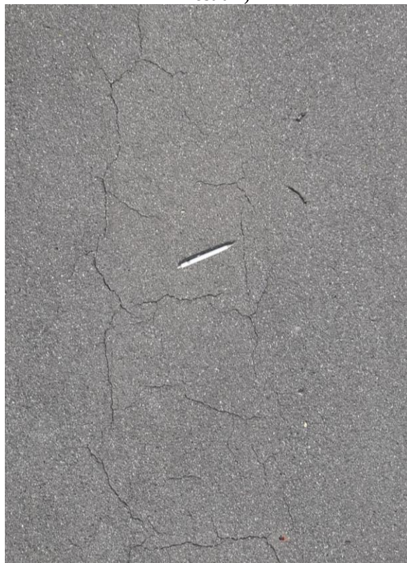
Fotografia 4 – Trinca couro de jacaré (Cabeceira 07 – Amostra 2)
