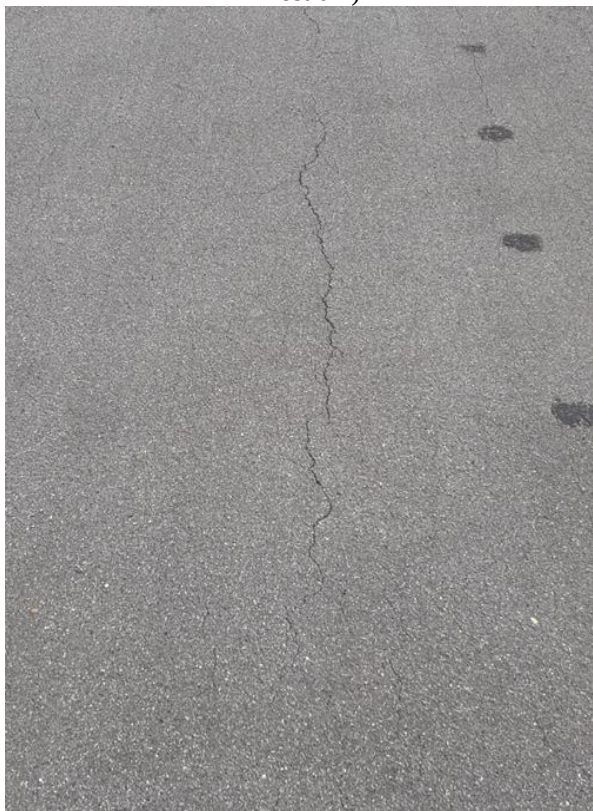
Fotografia 7 – Trinca longitudinal (Cabeceira 07 – Amostra 3)
