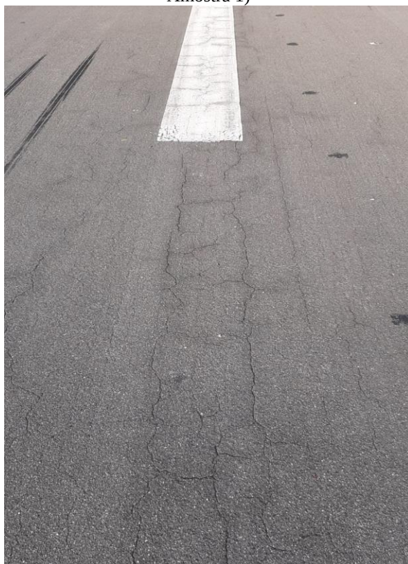
Fotografia 8 – Trinca couro de jacaré (Cabeceira 25 – Amostra 1)
