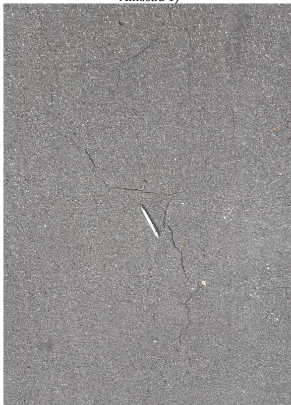
Fotografia 4 – Trinca couro de jacaré (Cabeceira 07 – Amostra 2)
