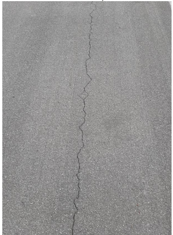
Fotografia 12 – Trinca longitudinal (Cabeceira 25 – Amostra 3)
