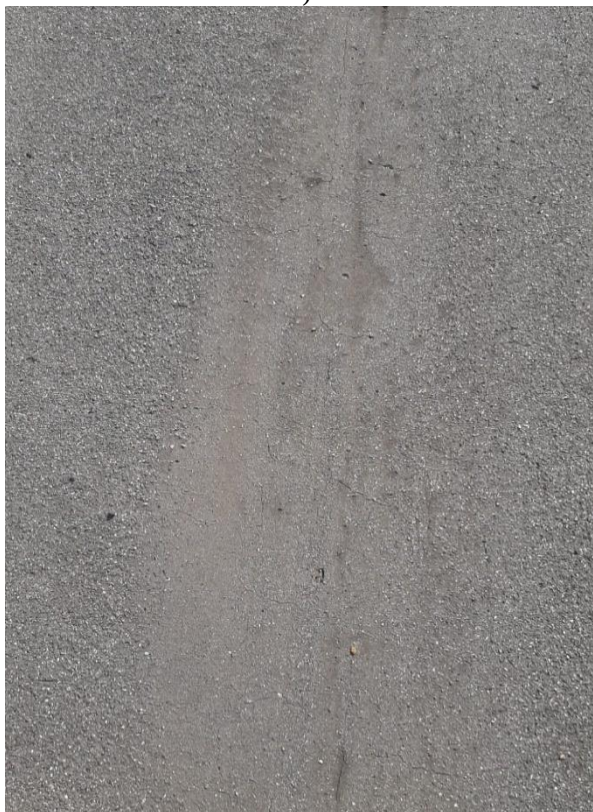
Fotografia 3 – Agregado polido (Cabeceira 07 – Amostra 1)
