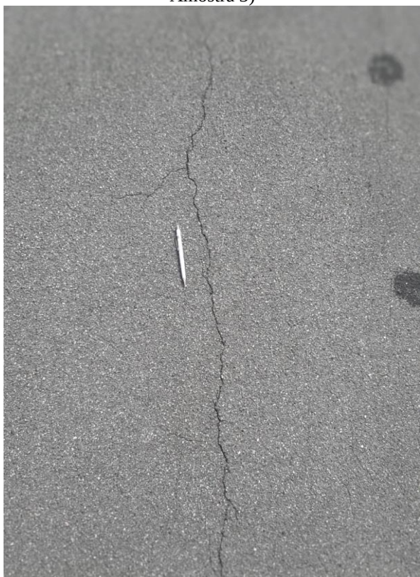
Fotografia 7 – Trinca longitudinal (Cabeceira 07 – Amostra 3)
