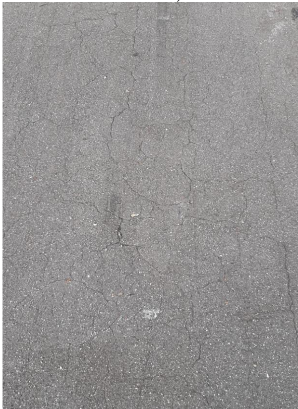
Fotografia 10 – Trinca couro de jacaré (Cabeceira 25 – Amostra 2)
