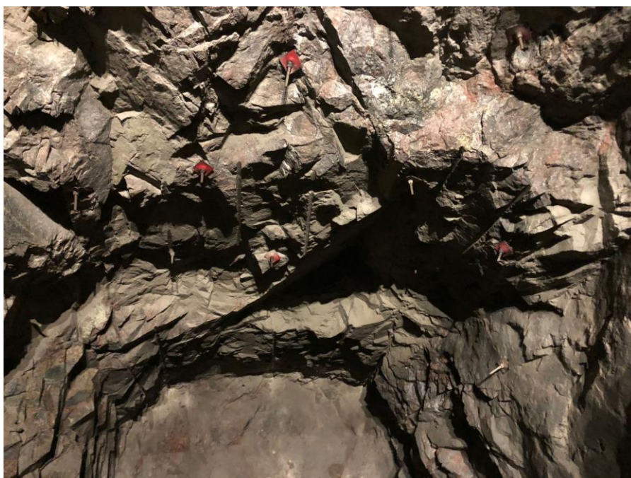
Figura 34 - Marcação da chapa do tirante por letra.
