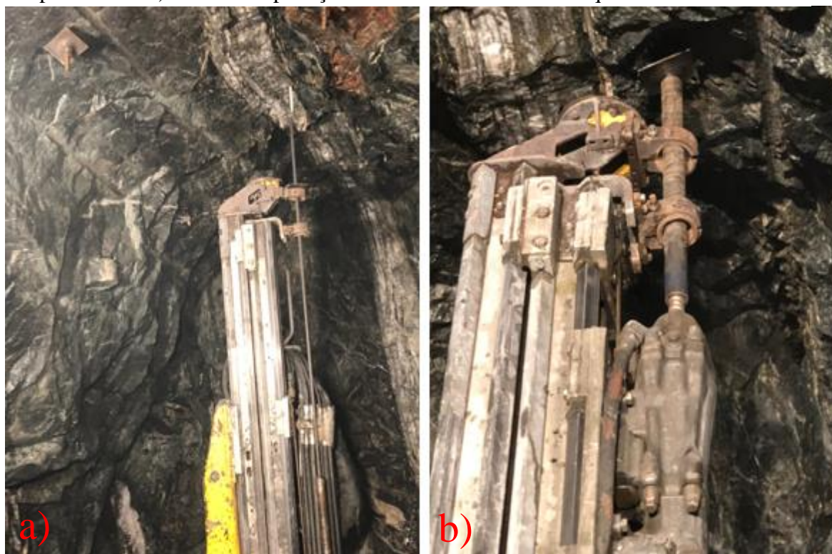
Figura 24 - Chave de aplicação do tirante. a) Chave de aplicação do tirante acoplada na perfuratriz. b) Chave de aplicação de tirante realizando o torqueamento.
