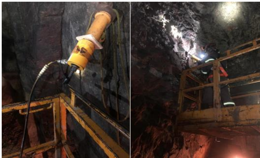
Figura 28 - Execução de um ensaio de arrancamento.
