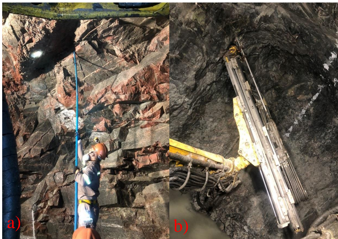
Figura 26 – Resinamento de furo para atirantamento. a) Resinamento Manual; b) Resinamento mecanizado.
