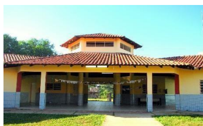
Imagem 7. Foto da fachada da Escola.
