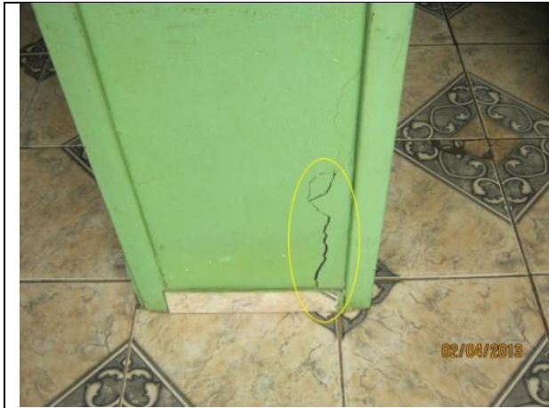
Foto 28 - Trinca vertical
