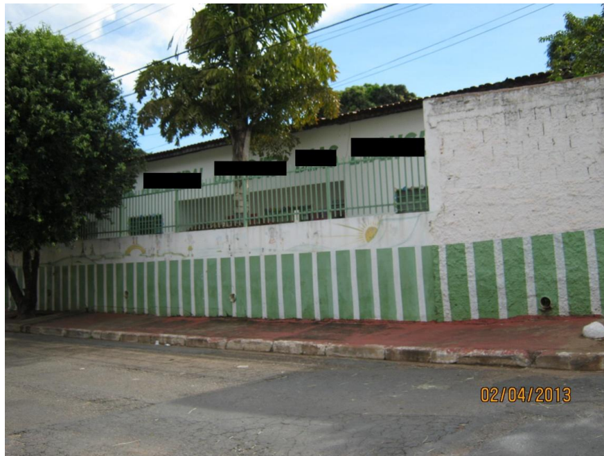
Foto 2 - Vista da fachada - Creche B
