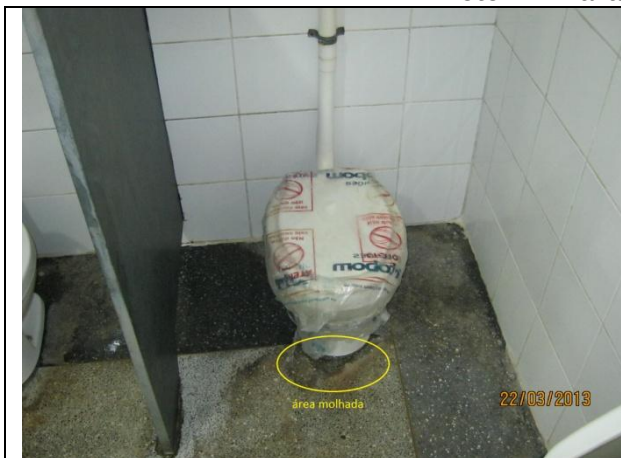
Foto 22 - Vazamento sanitário
