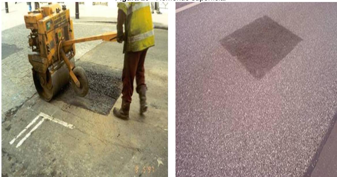
Figura 10 - Remendo superficial
